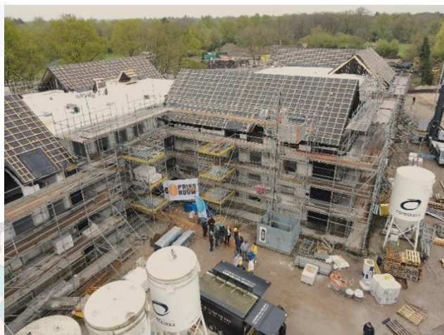
Figuur 1.2 Het woon-zorgcomplex Hokseberg in aanbouw
